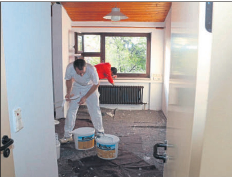
Sanierungsarbeiten: Vorbereitungen für den Umzug der Verwaltung.
